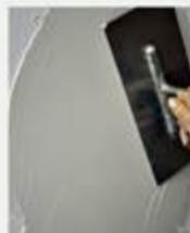
Trockenbauplatten zunächst nach Herstellerangaben Stöße verspachteln und flächig grundieren. Beton, Kalksandstein und Lehmbauplatten direkt verputzen. Beachten Sie die Vorschriften zur Vermeidung von Bau- und Feuchteschäden. Für größere Putzarbeiten und Untergrundbestimmung empfehlen wir einen Fachbetrieb zu beauftragen.
